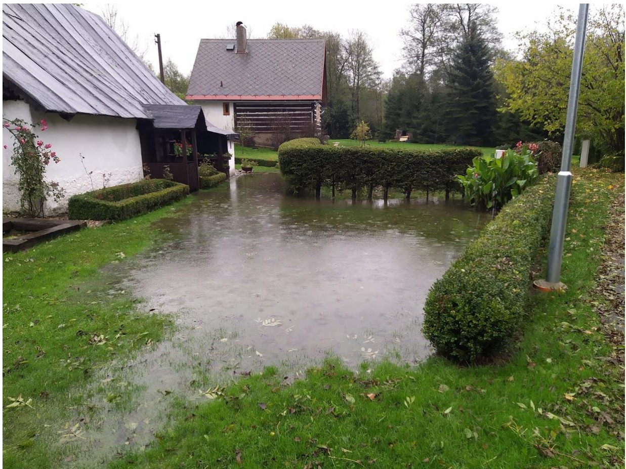
Opětovný problém s vodou u čp. 22
