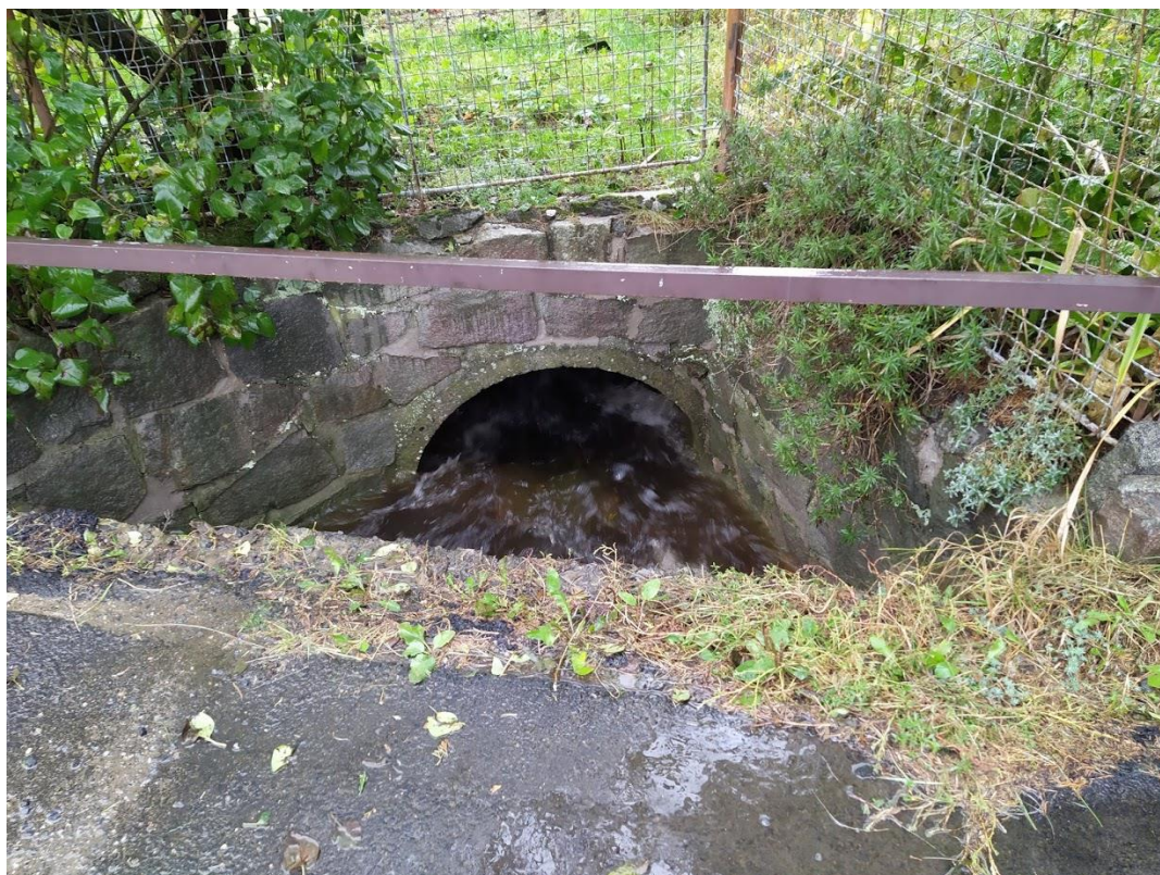
Prohlídka nekapacitního propustku u čp. 129 na toku Kamenická voda
