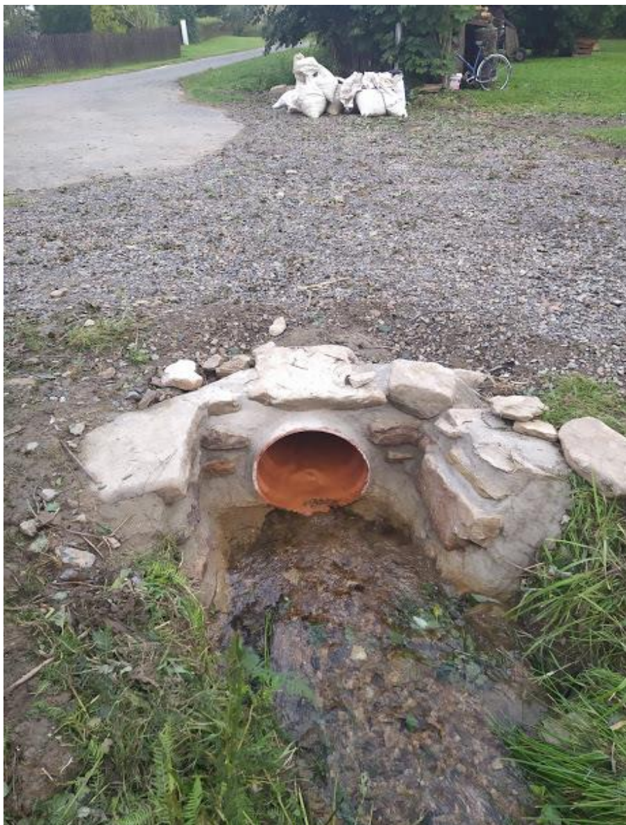
Fotografie z oprav propustku u domů čp. 117 a čp. 134
